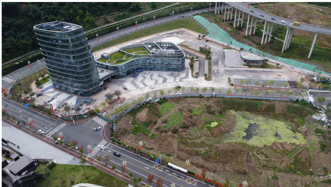
图 2.1-2 项目现状照片
