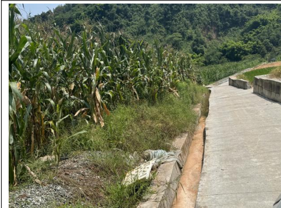
项目弃土场排水沟现状 5
